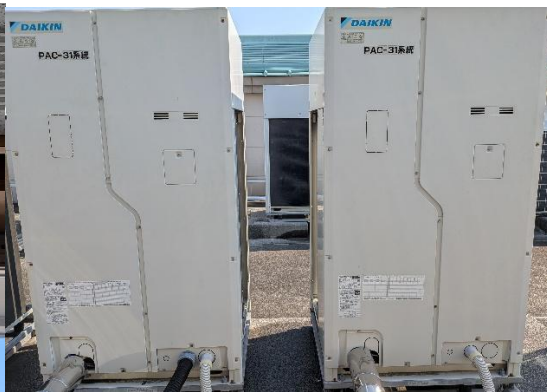
空調設備基板交換
