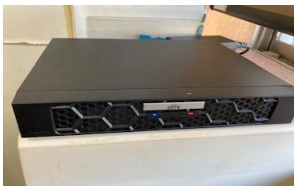
防犯カメラ設置工事①
