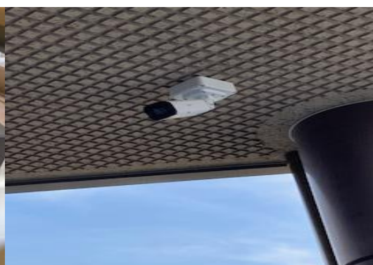
防犯カメラ設置工事②
