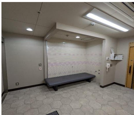
1 北脱衣場改修工事①
