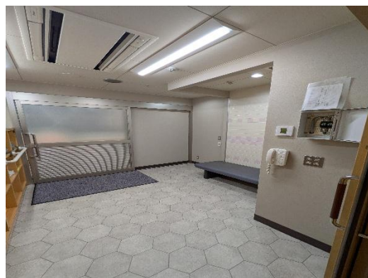
1 北脱衣場改修工事②
