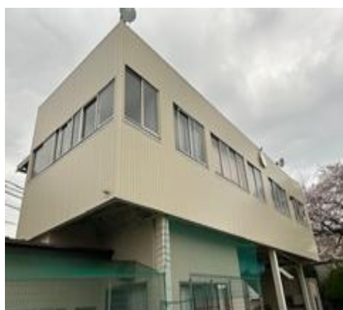
【学習室外壁補修】
