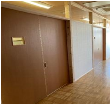
特養 1 階南改修工事
