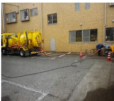
【本園北側排水管洗浄工事】
