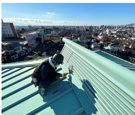
特養屋上雨漏り工事
