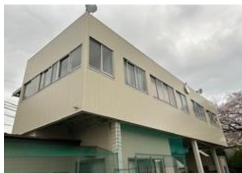
【学習室外壁補修】
