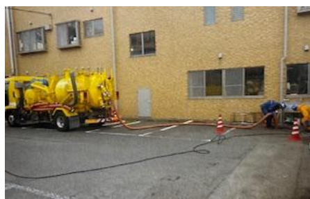
【本園北側排水管洗浄工事】
