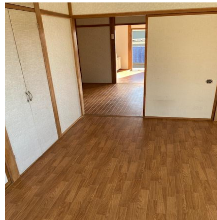
社員寮 203 号室改修工事
