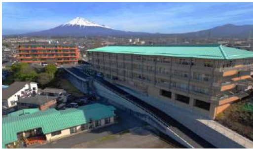
進入路造成工事完成
