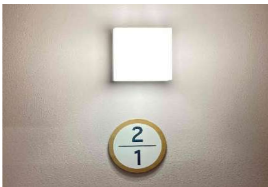
階段中段センサー付き LED
