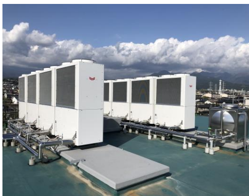
【エアコン室外機更新工事】
