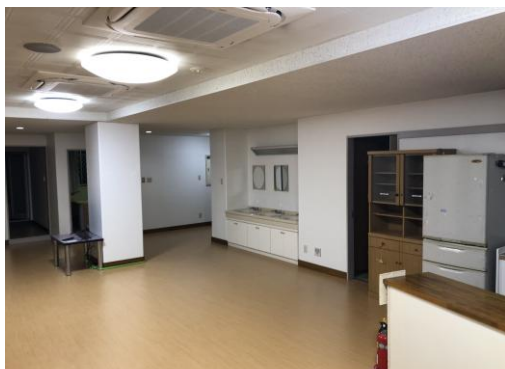
【ユニットホール床の張り替え】
