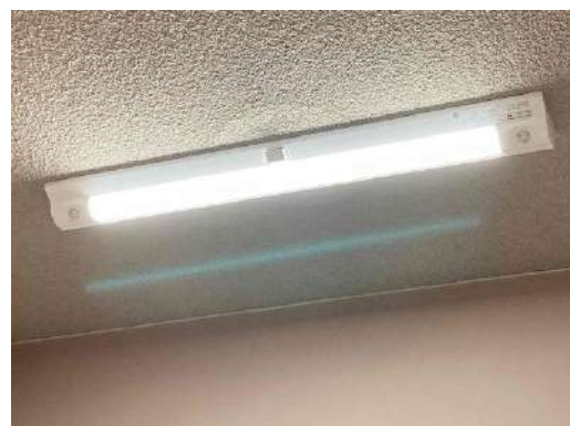
照明階段灯センサー付 LED 照明
