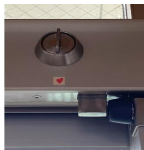
3F 電子錠から手動鍵へ改修
