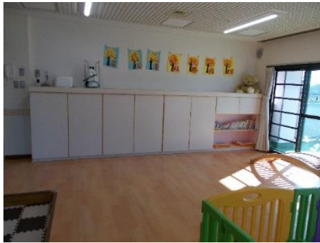
遊戯室改修工事
