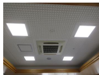
3 エリア LED 照明工事
