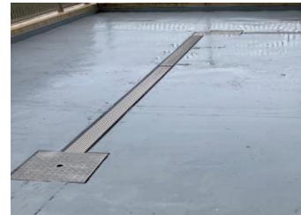
ベランダ側溝蓋工事
