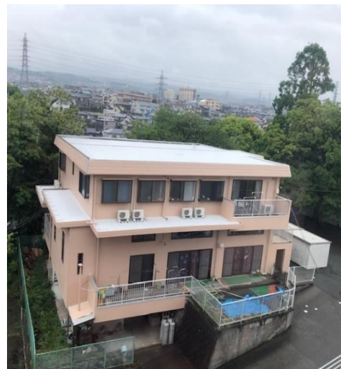
【環境改善による外壁塗装】
