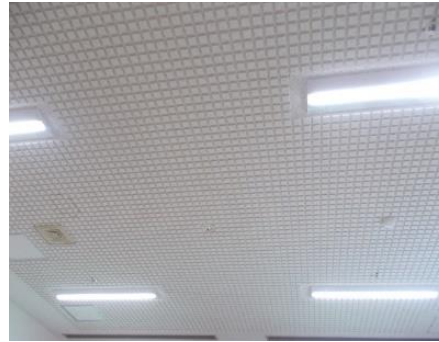
LED照明工事
