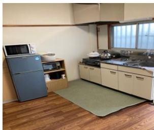
技能実習生宿舎改修工事
