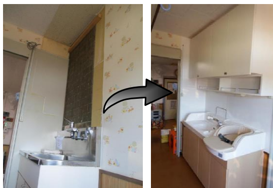
診察室の改修
