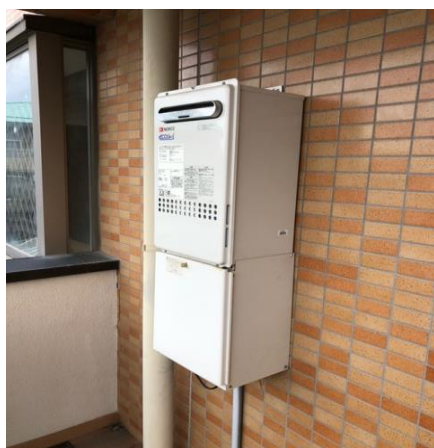
【ガス給湯器取替】
