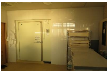
厨房プレハブ冷蔵庫
