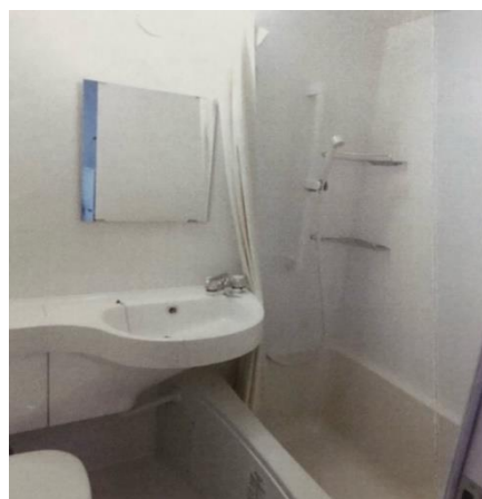
【ユニットバス設置】
