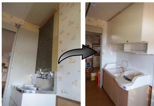
診察室の改修
