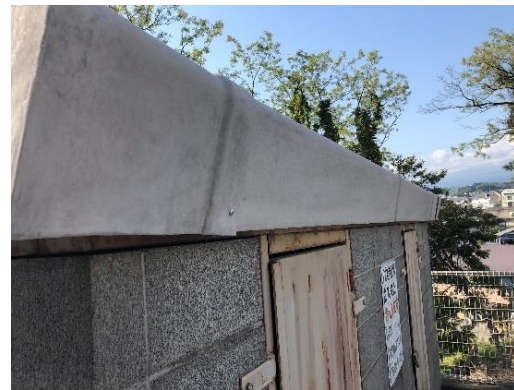
【 プロパンガス倉庫屋根 】
