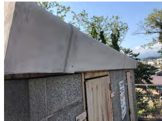
【 プロパンガス倉庫屋根 】
