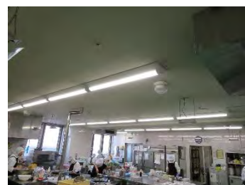
地下部：LED照明設備（4期完了）
