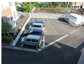
駐車場拡張整備
