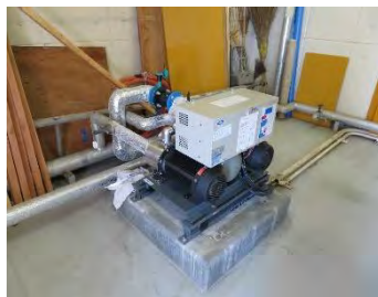
本館地下加圧送水ポンプ入替
