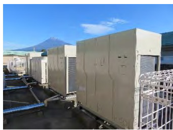
本館空調設備更新工事：居室・屋上・厨房等设备（室外機マルチ型他：27台・全設備：136台）
