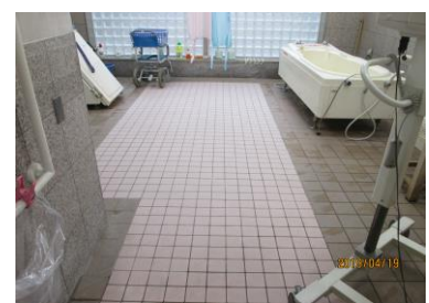
ユニット浴室床の改修
