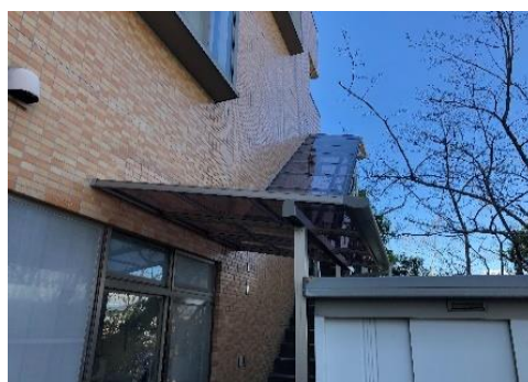
【ひまわり園厨房外階段屋根工事】
