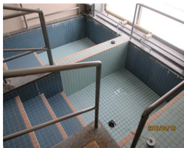
ふようデイ浴室改修 2層浴槽
