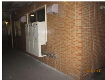
ふようデイ給湯ボイラー改修
