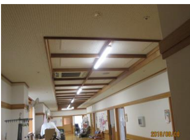
ユニット内 LED 照明改修
