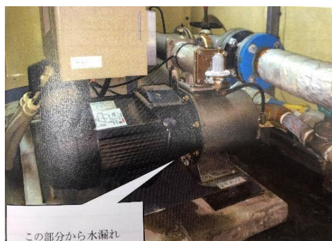
【給水ユニット修繕工事】
