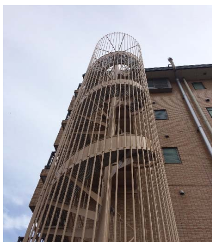
【 非常滑り台塗装工事】
