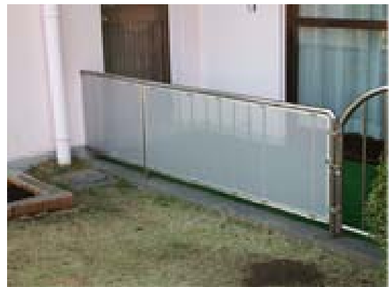
改善後：パンチングメタル貼付、手が出ない
