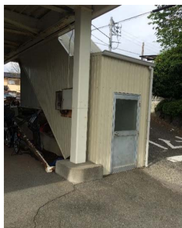
【 学習室外壁補修 】
