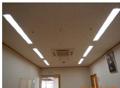
LED照明入替え
