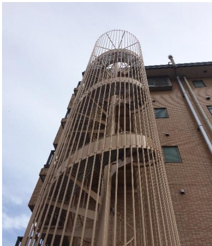
【 非常滑り台塗装工事】
