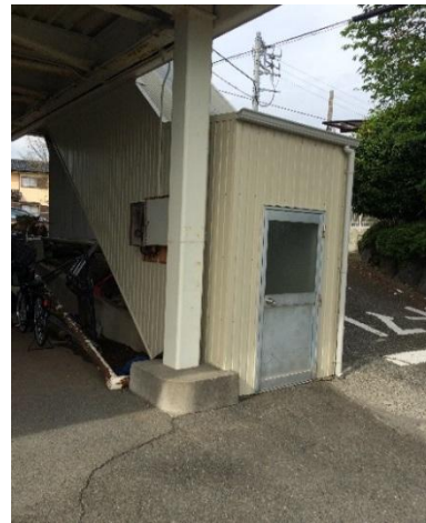
【 学習室外壁補修 】
