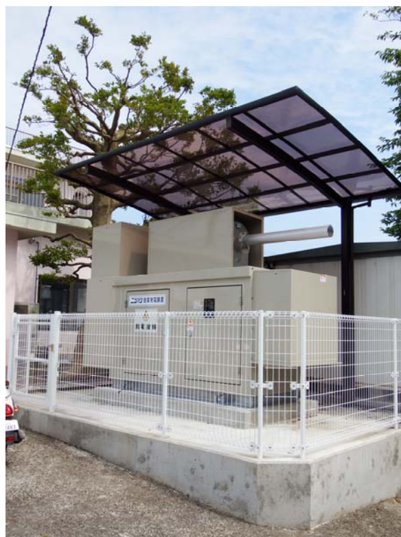
防災型非常用発電装置
