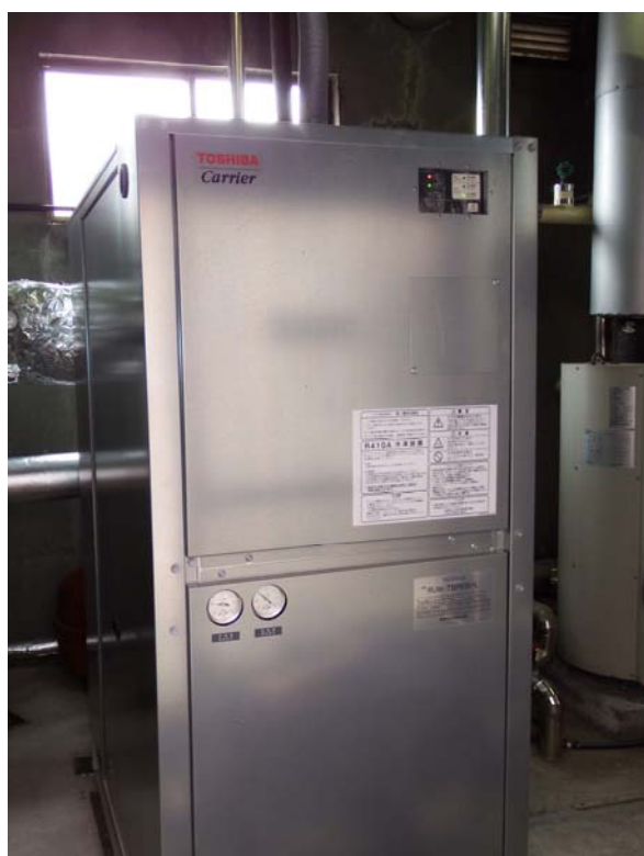
冷房用チラーユニット
