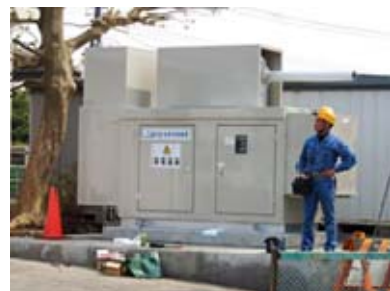
設置完了 : H29.3.30
