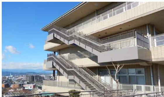
南・北非常階段の全塗装修繕
