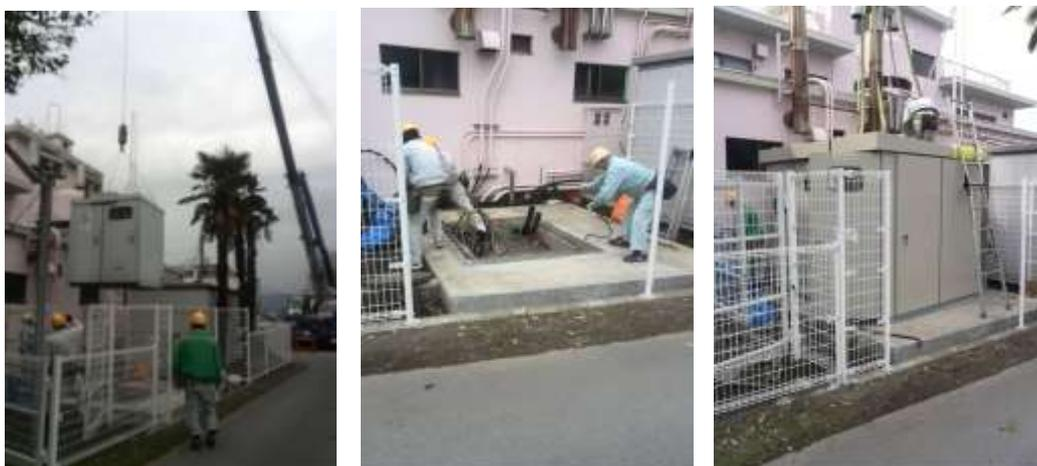
古い受変電設備が撤去され、新しい設備が設置されました。
