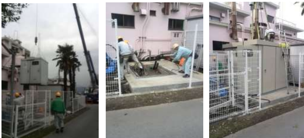
受変電設備取替工事 (2016.2.24)
