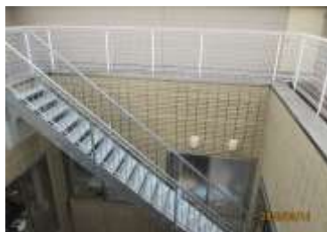
屋上進入路階段
