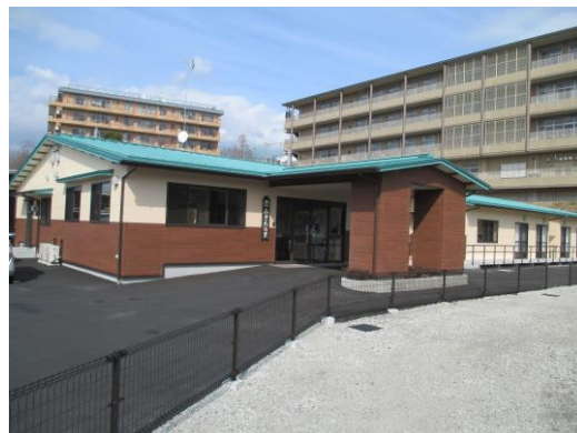
完成したみぎわの里正面
