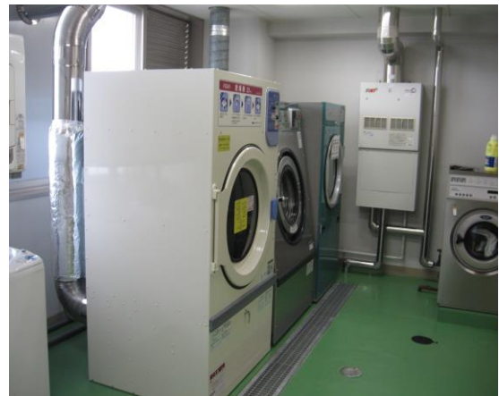
ランドリー改修と大型機洗濯機械
