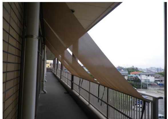
みぎわ園西面遮光シート
