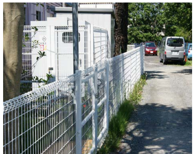
園舎北側及び キュービクルフェンス取換
