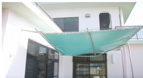
1階食堂前日除けの破損状況
