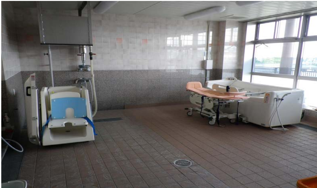
改修後：1 南ユニット浴室と機械浴装置
