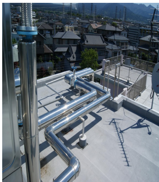
設備取換え後の屋上高架水
