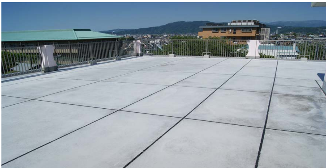
防水工事後の屋上：手摺りも取換え
