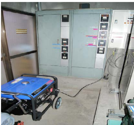
発電機による 非常用電源使用揚水システム
