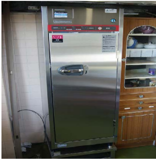
2階 食器消毒保管庫
