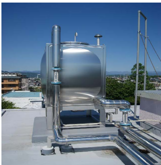
取換え後の高架水槽
