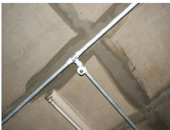
スプリンクラー配管・ヘッド（機械室）
