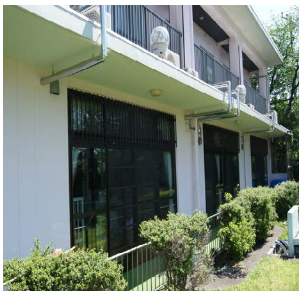
1階居室のサッシ取換え（面格子
