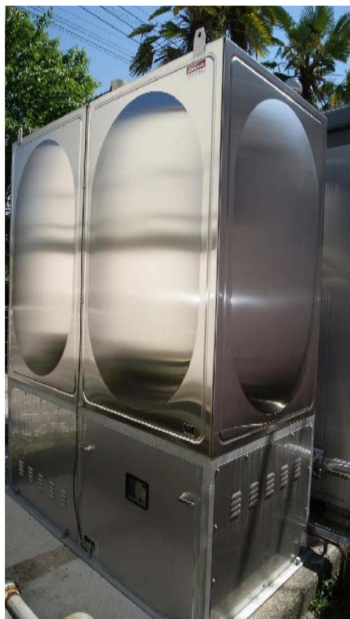
スプリンクラー用タンク
