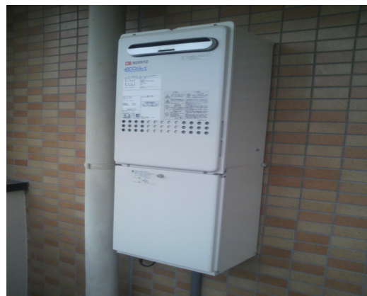
【風呂用給湯設備】
