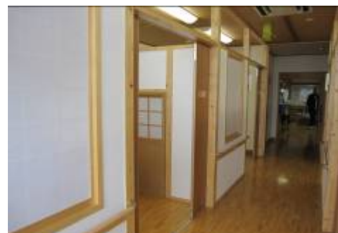
ショートステイ居室改修
