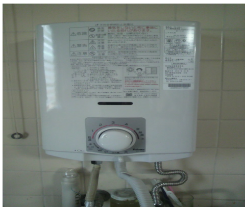
【台所用給湯設備】
