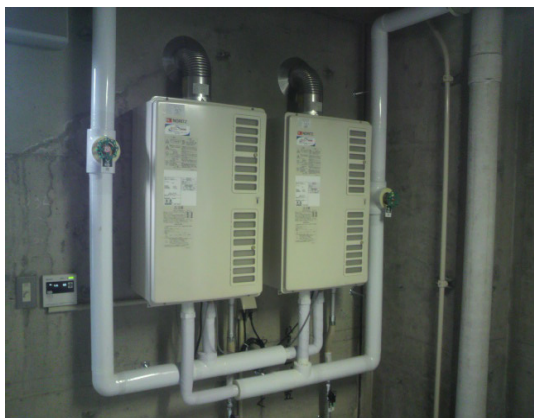
【厨房等給湯設備】
