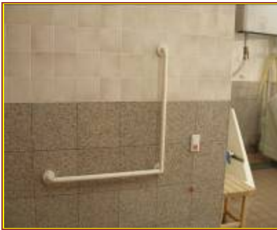
浴室・脱衣室設置手すり
