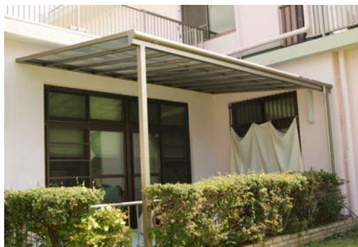
1階食堂テラス屋根取替補修
