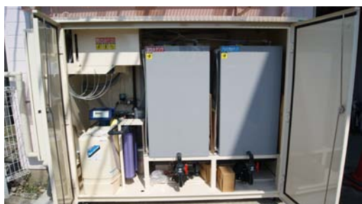
電解水生成システム：本体
