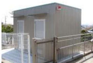
井戸ポンプ建屋
