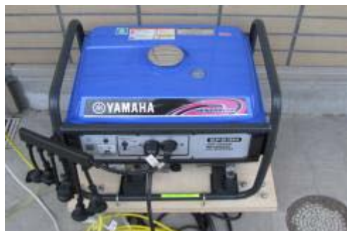
非常用発電機×2
