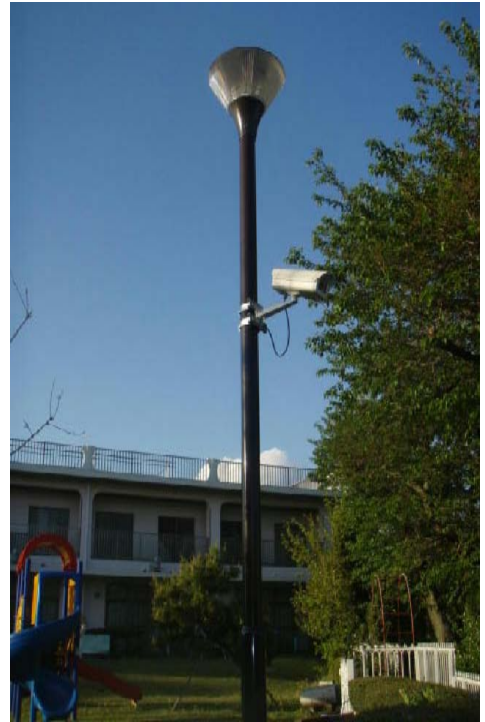
園庭照明取替修繕工事
