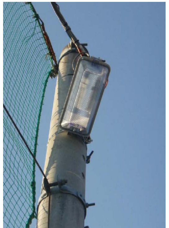
園庭照明取替修繕工事
