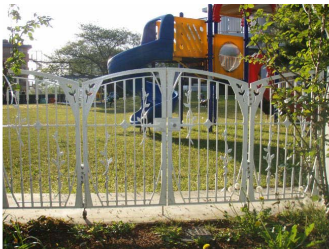
園庭門扉取替修繕工事
